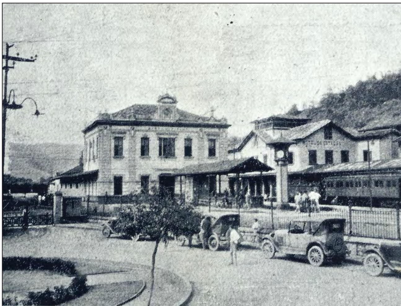
Foto da Praça Heitor Vale, tirada por volta de 1920, onde podemos ver o elegante conjunto formado pela Estação Ferroviária, o Hotel da Estação e o belíssimo Relógio. Ainda não havia sido construído o subterrâneo. A praça era charmosa e bem cuidada. Nela, como podemos ver, havia um movimentado ponto de taxi que atendia aos viajantes.
