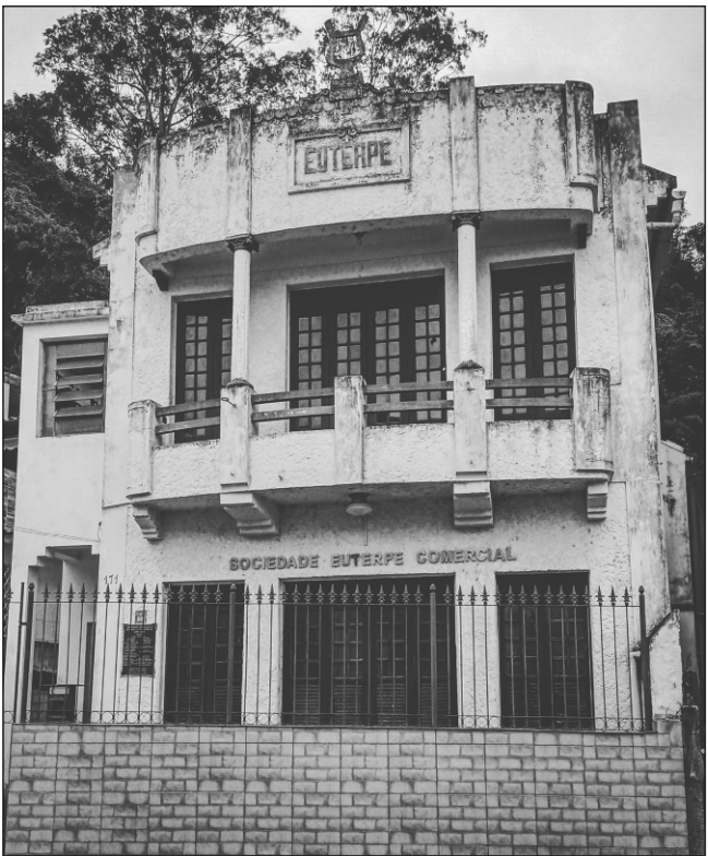
Fachada da Sede situada na Rua Major Ferraz
