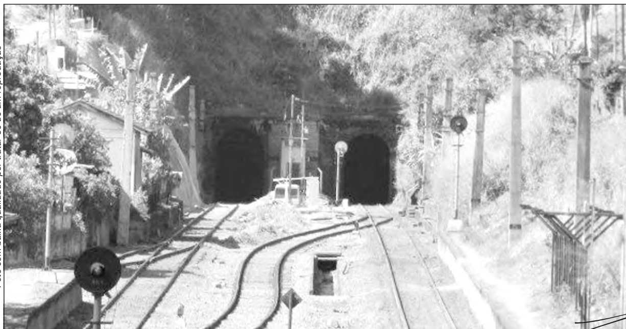
Pátio da Estação de Humberto Antunes, ao fundo o Túnel Grande.
